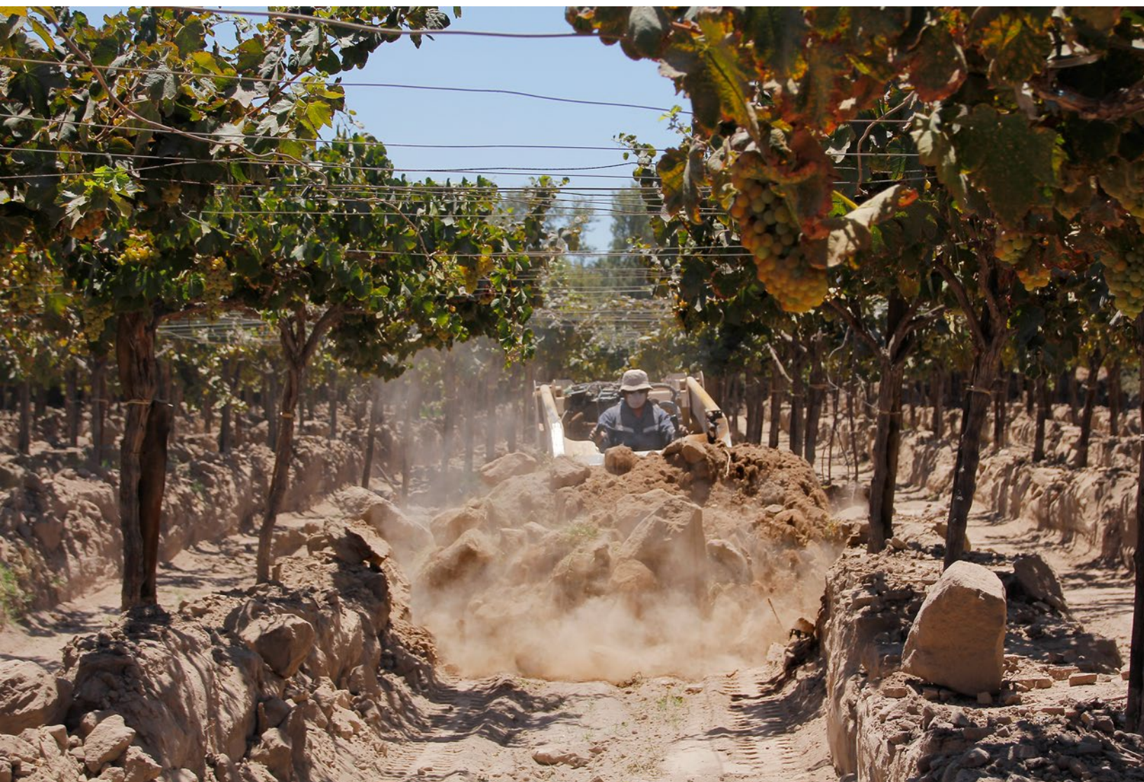
Retiro de lodos por emergencia. Región de Atacama.
