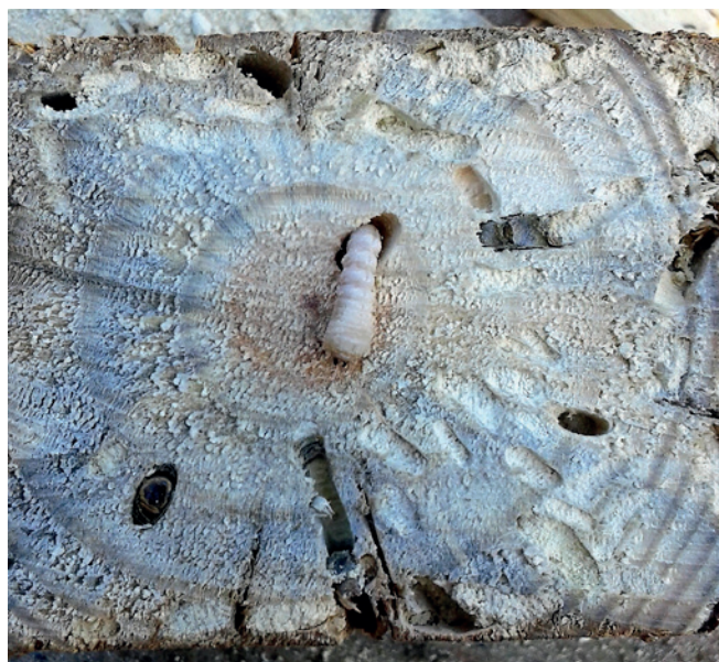
Figura 5. Larva de Hylotrupes bajulus en viga estructural (Fuente: SAG Región de O'Higgins).
